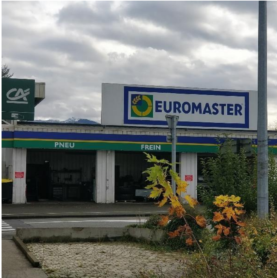
Une enseigne en toiture interdite.
