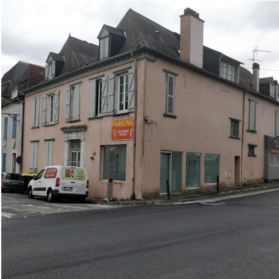
Préenseigne trop importante, posée sur un mur non aveugle, en SPR.
