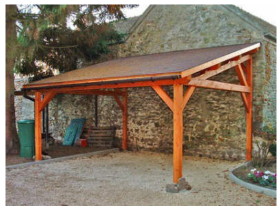
Abri de protection accolé à bâtiment (adjonction)
