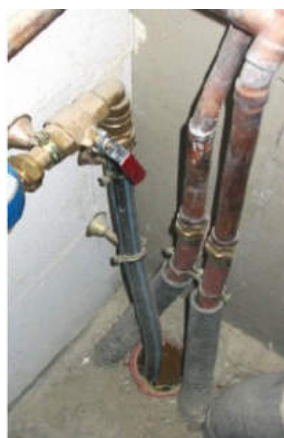
Exemple d'entrées de réseaux à calfeutrer
