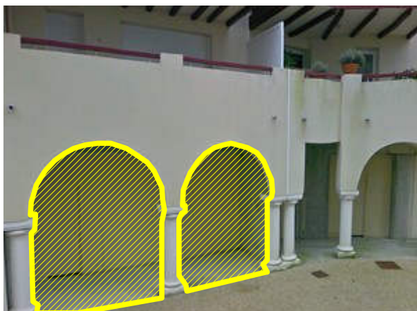
Obturation d'une travée de galerie
