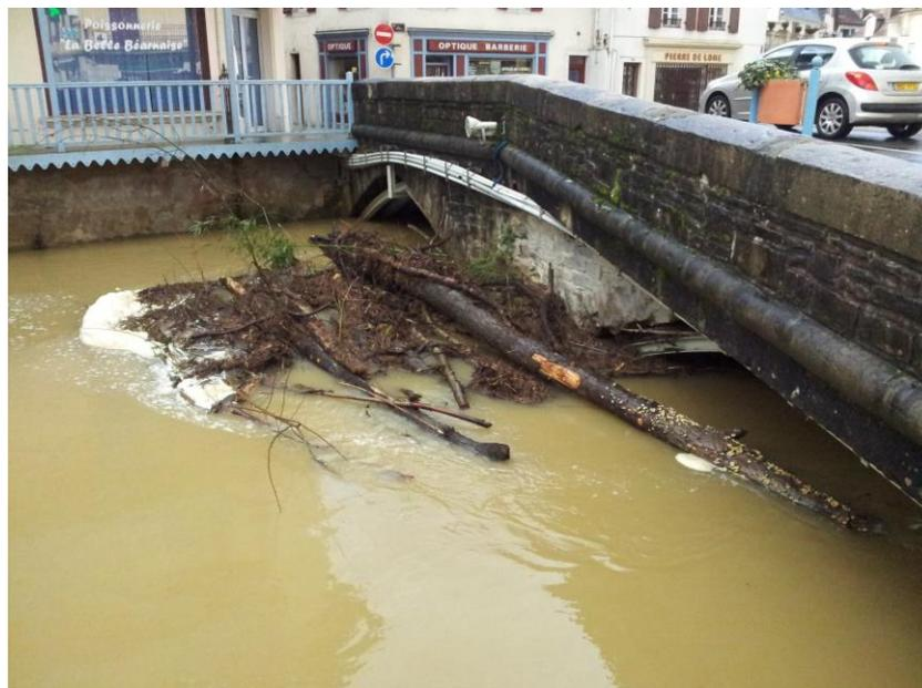
**Fig. 17. Embâcles au pont de la lune**
