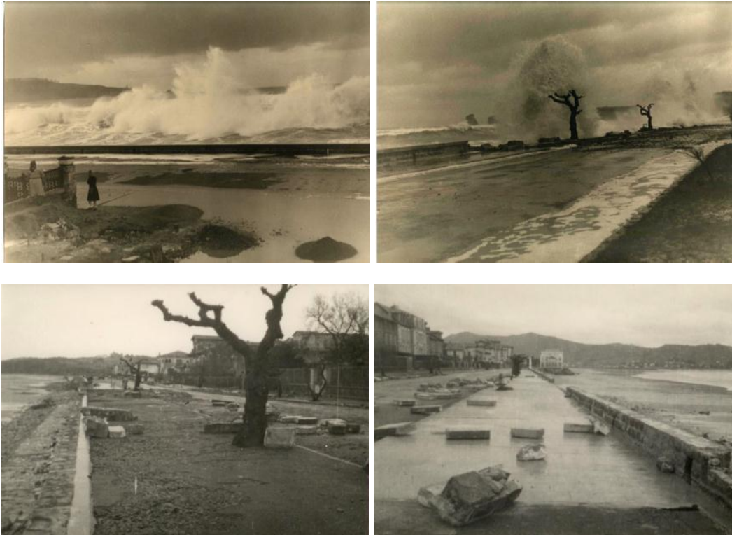
Figure 21 : Tempête de 1951, type de submersion observable et illustration des dégâts occasionnés sur le perré.
