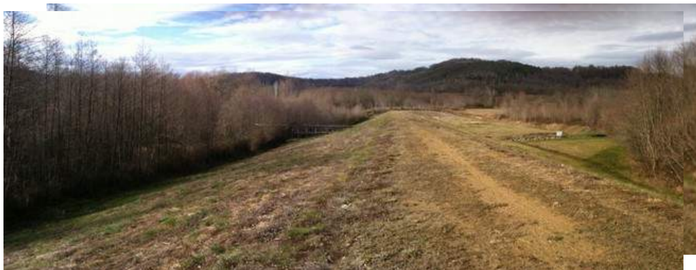
FIG. 6 : Photo du barrage écrêteur de crues des « Mielles »
