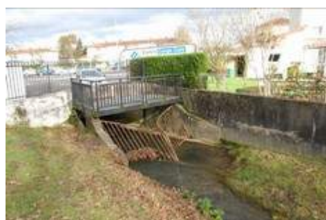
FIG. 18 : Ouvrage et canalisation de la « Mielle »
