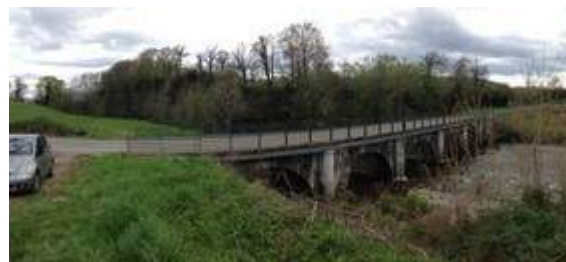
Pont sur la RD 24
