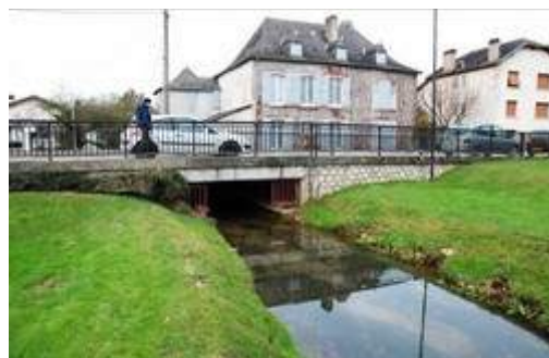
FIG. 22 : Ouvrage de franchissement Rue Tristan DEREME
