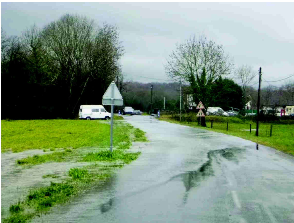
Figure 44 : Passage d'eau sur la RD 213 (source DDTM64)
