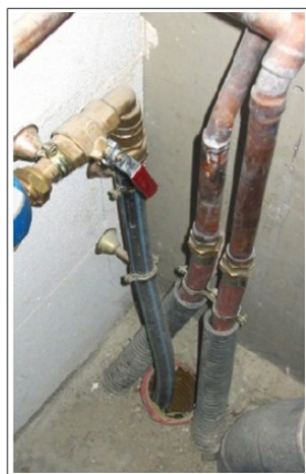
Exemple d'entrées de réseaux à calfeutrer
