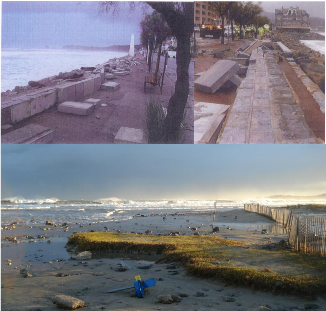
Figure 24 : Dégâts occasionnés sur le perré et érosion de l'herbier de la plage d'Hendaye, durant la tempête du 9 novembre 2010.
