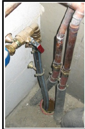
Calfeutrage des entrées de réseaux
