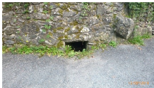
[14] Ci-contre à gauche : chenal souterrain en pierres aboutissant sur le chemin de Lats.
