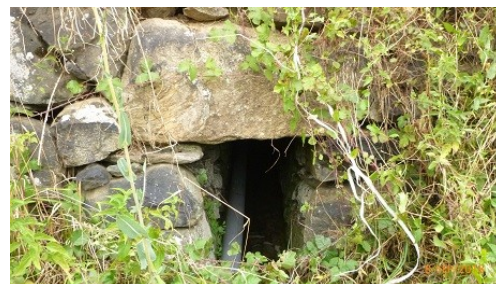
[40] : en amont du quartier de Casamajor, le long de la RD294: chenal souterrain en pierres sèches drainant les eaux de source.
