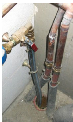
Exemple d'entrées de réseaux à calfeutrer
