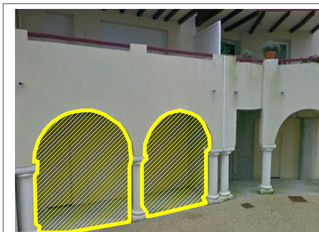
Obturation d'une travée de galerie
