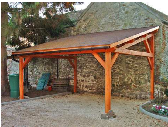
Construction annexe adossée
