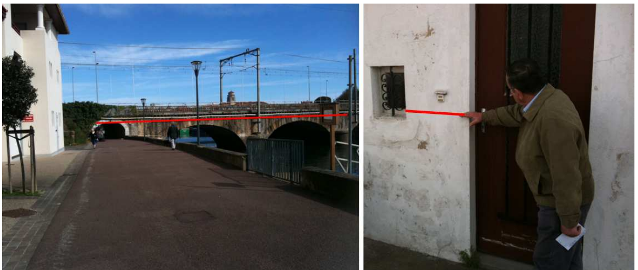
Fig. 8. TMOIGNAGES DES NIVEAUX ATTEINTS LE 28 SEPTEMBRE 1959
