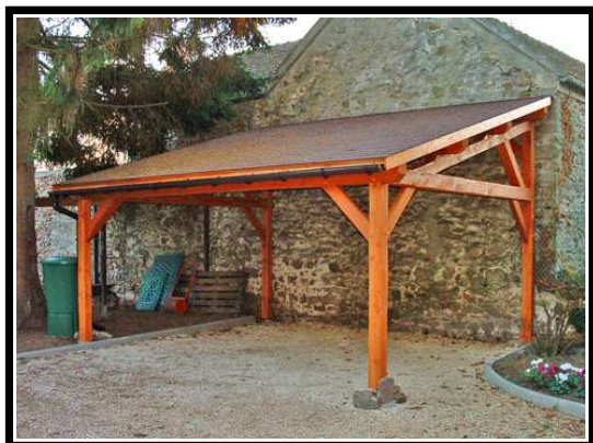
Construction annexe adossée
