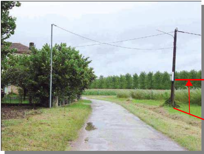
Exemple de mise hors d'eau de compteur électrique
