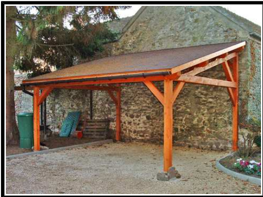
Construction annexe adossée
