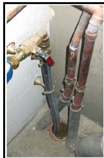
Calfeutrage des entrées de réseaux
