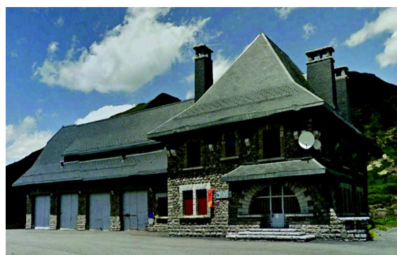
Bâtiment des déneigeuses au col du Somport
