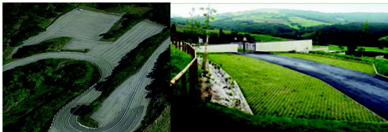
Possibilité d'évolution des aires de stationnement, mais limitée à cause des chasse-neiges
