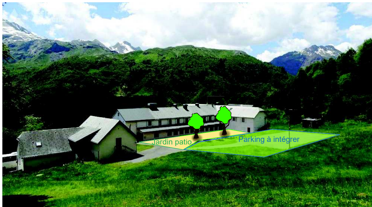
Exemple d'intégration du parking dans la pente au-dessus de l'hébergement (source APGL)
