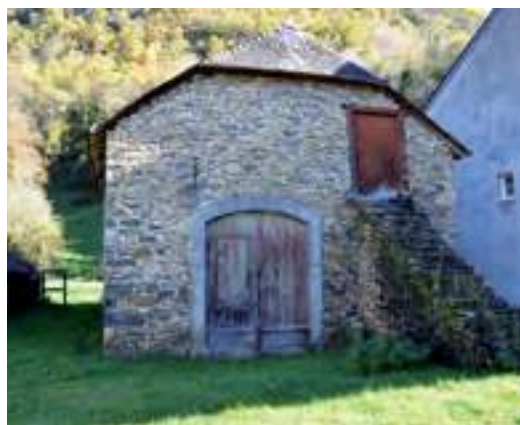
Porte de fenil et rampe d'accès à Aste-Béon.
