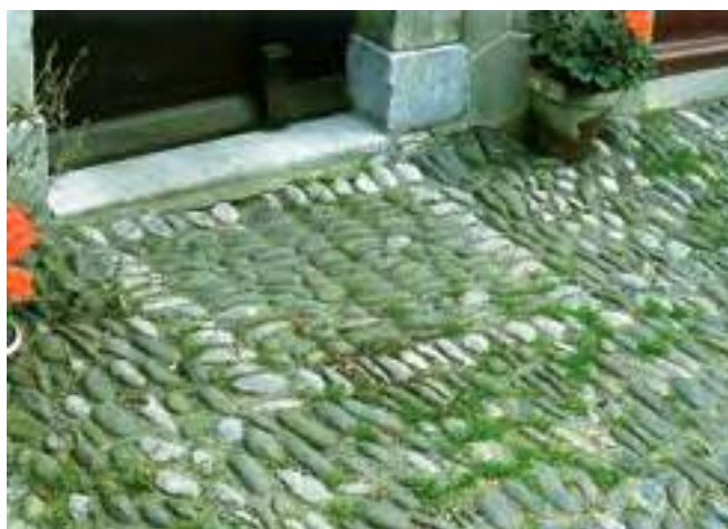
Seuil. Bedous © CAUE 64.
