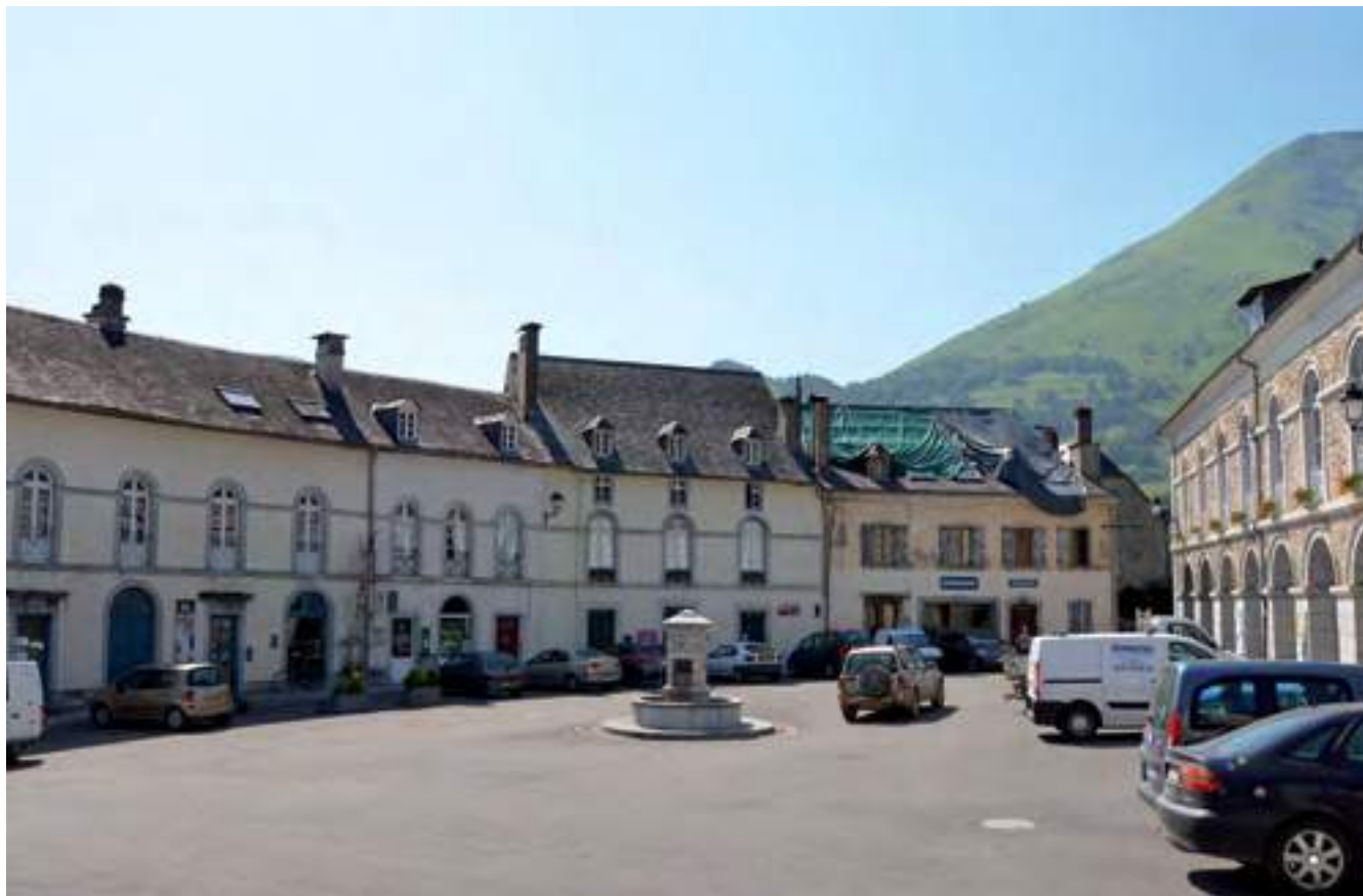
La place ordonnée, le rythme des façades fait écho aux arcades de la mairie-halle, le gabarit des maisons est réglé sur celui de l'hôtel de ville à R+1+ comble. La fontaine au centre de la place est l'équipement communautaire qui articule l'espace public. Bedous.
