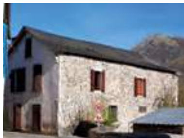
Toiture simple à deux pentes. Bielle.
