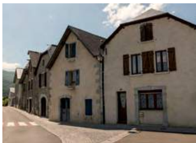
Le faitage est perpendiculaire à la rue. La façade principale est sur le mur pignon. Maisons à Arudy.
