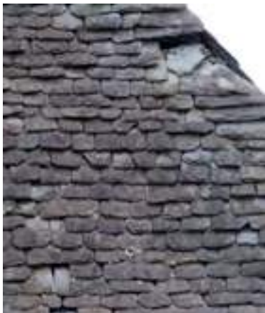
Ardoises épaisses posées au clou. Oloron Sainte-Marie.
