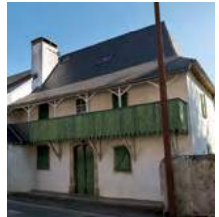
Le pan du coyau est prolongé pour servir de couverture à la galerie ouverte. Féas. Source : VPAH © C. HERBAUX.
