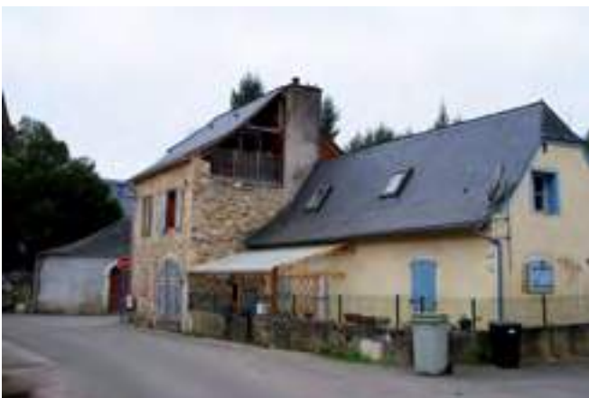
Hiérarchie des bâtis : le logis est enduit, la grange ne l'est pas. Verdets.
