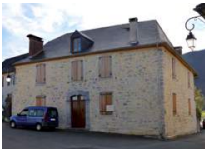
Enduits à pierre rase. Lucarne unique dans la travée centrale. Sainte-Colome.
