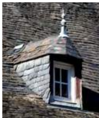
Lucarne à croupe avec épi de toit en zinc, joues en ardoise. Gère-Bélesten.
