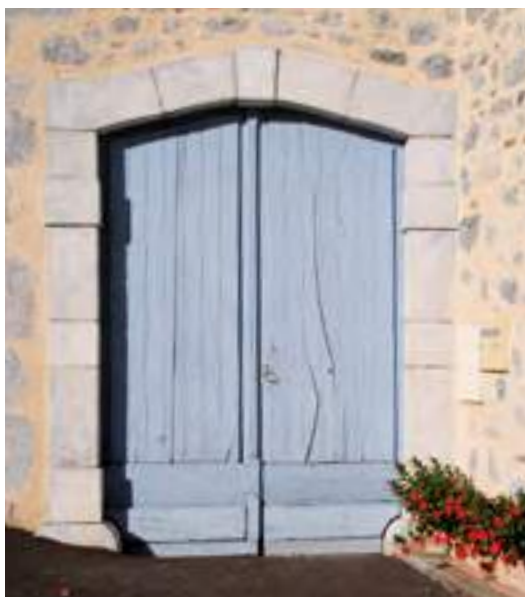
Porte à planches et contre-planches. Bescat.
