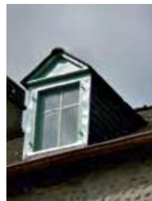
Lucarne jacobine, fronton en bois peint avec corniche, ardoise. Gurmençon.
