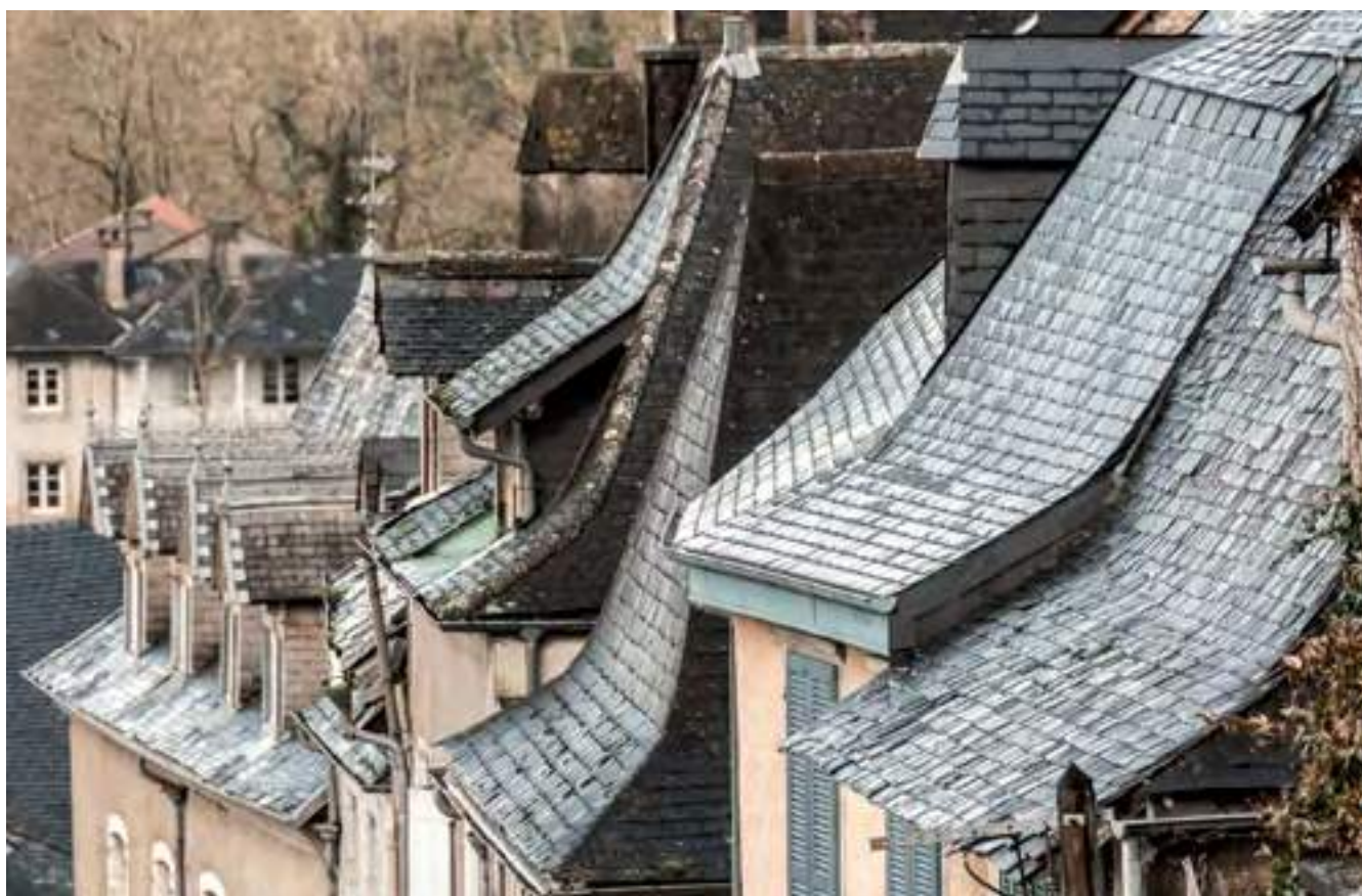
Succession de toits en ardoises avec coyaux, intégrant des lucarnes. Oloron Sainte-Marie. Source : Pays d'art et d'histoire © Clément HERBAUX.
