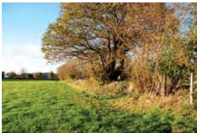
Murets séparatifs en galets aujourd'hui totalement colonisés par la végétation. Entre Aste-Béon et Louvie Soubiron.
