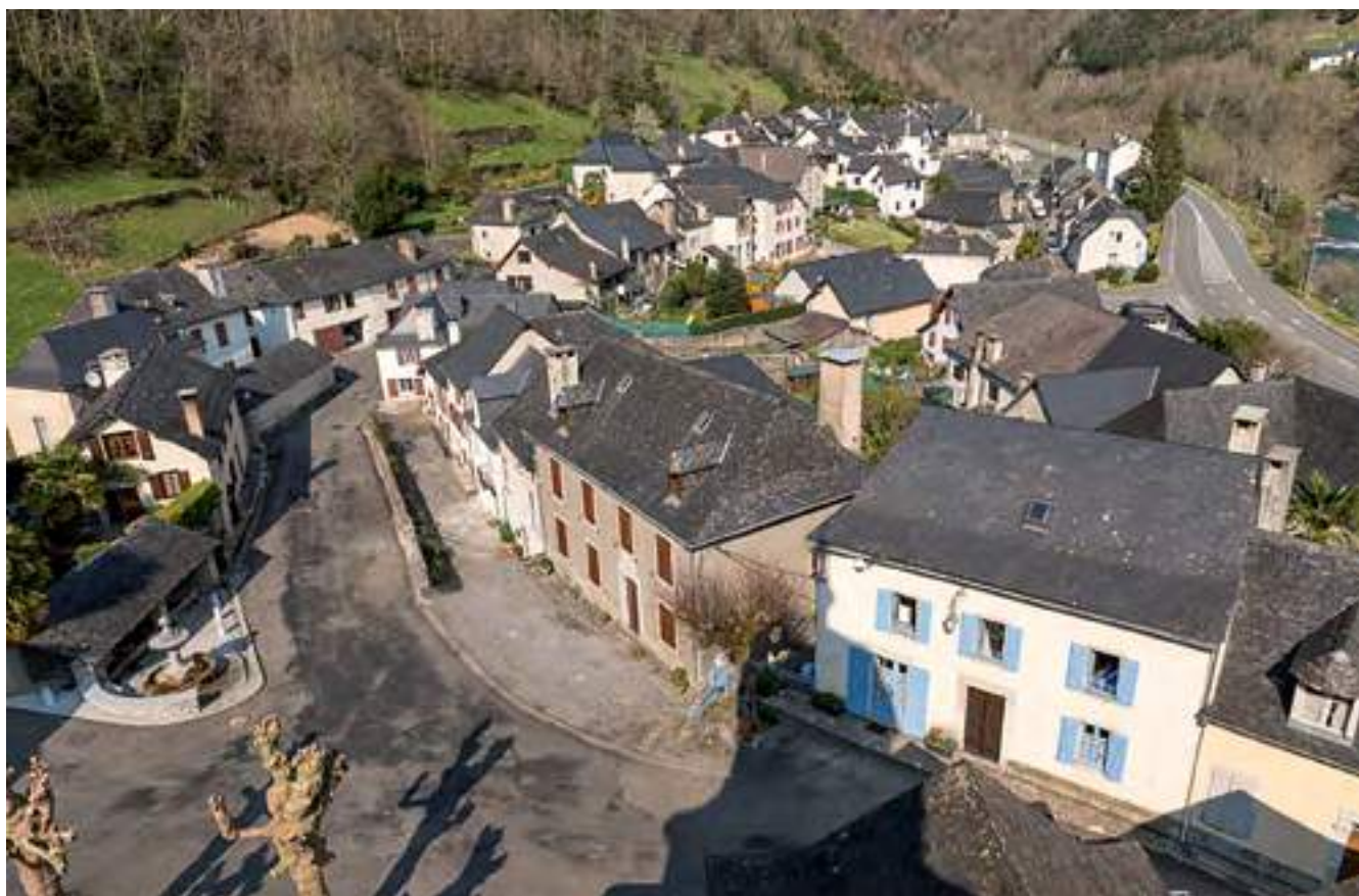
Vue des îlots bâtis. Sarrance.
