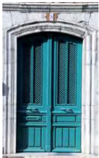
Porte avec sa ferronnerie. Oloron Sainte-Marie.
