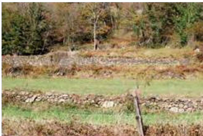
Terrasses et murs de soutènement en pierres sèches qui facilitent le drainage des terrains. Entre Bielle et Bilhère, vallée d'Ossau.
