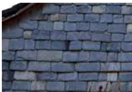
Ardoises posées au clou pour le bardage d'un pignon de grange. Sainte-Colome.
