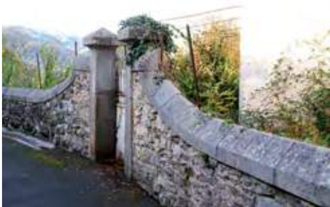
Muret à Sévignacq-Meyrac.
