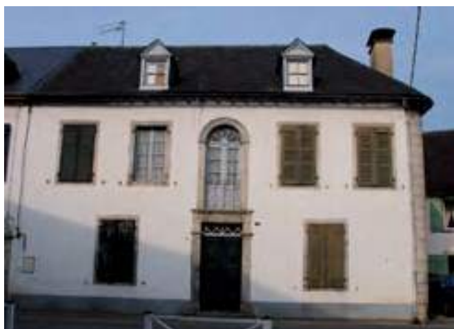
Façade enduite permettant une mise en valeur des encadrements. Arette.
