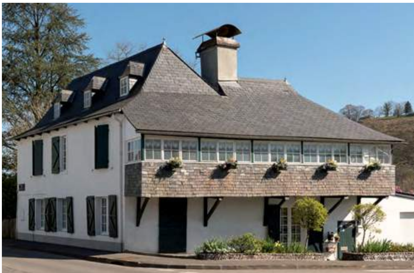
La galerie fermée est une extension de la maison qui présente des propriétés climatiques intéressantes en jouant le rôle d'espace tampon sur la façade. En hiver grâce à l'inertie thermique des ardoises elle emmagasine la chaleur du rayonnement solaire pour la redistribuer à la maison. Féas. Source : Pays d'art et d'histoire © Clément HERBAUX.
