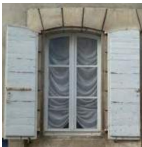
Fenêtre XVIII e siècle, partition à grands carreaux, volets en planches et contre-planches qui s'inscrivent dans la feuillure de l'encadrement.
