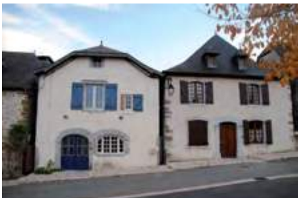
Maisons avec pignon sur rue à Rébénacq.
