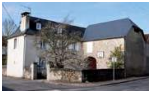
Maison et grange formant une cour. Verdets.
