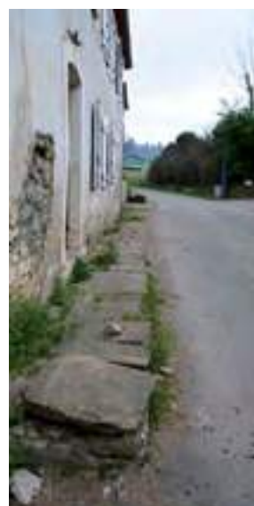
Dalles de pierres marquant le seuil. Estialescq.
