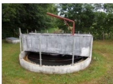
Ex. d'ouvrage en béton
