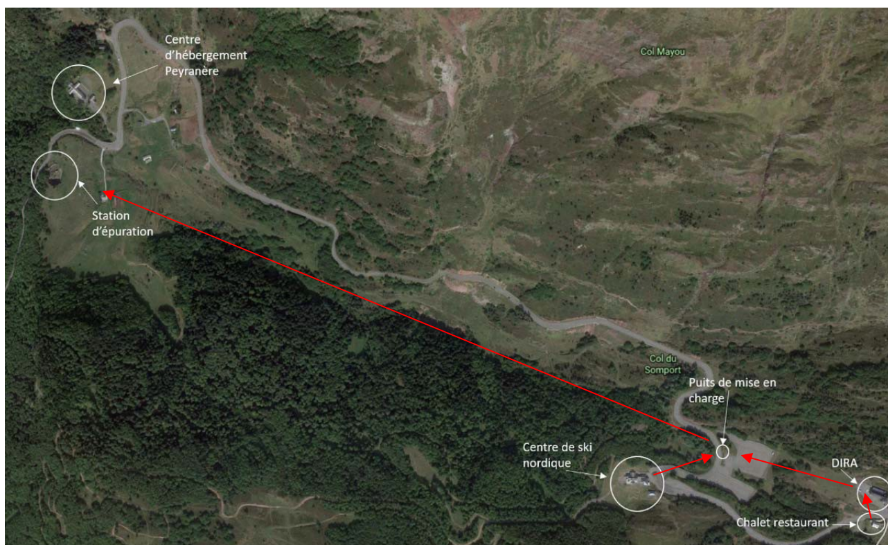
Le réseau d'assainissement sur le Somport
