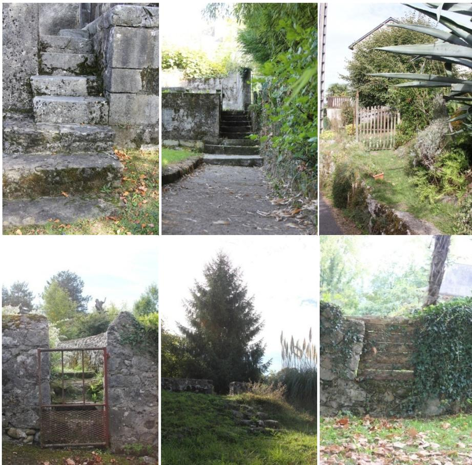
La commune s'est implantée sur ce site en composant avec le terrain. Pour la faire évoluer, il a fallu modeler la pente au moyen de murs de soutènement, qui soulignent le paysage et suivent les courbes de niveau. Ainsi a-t-on pu libérer des espaces plats, propices aux cultures, au développement des routes...
