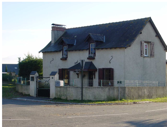
Restauration de l'ancien bâti
