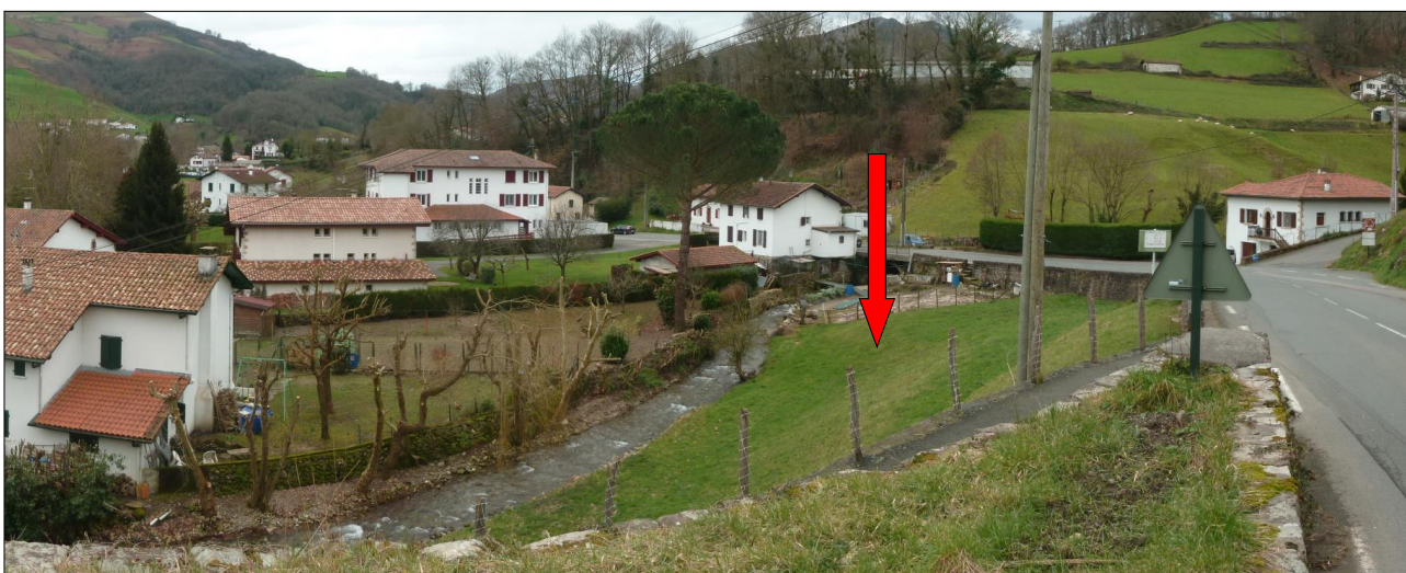
Vue sur un terrain situé dans l'enveloppe urbaine du hameau Lespars concerné par des contraintes topographiques, de recul par rapport au cours d'eau et d'accessibilité, limitant fortement sa construction. Source : APGL. 2018.
