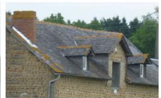
• A Barinque, toit d'ardoises, cheminées en briques, lucarnes droites, encadrements en bois et pierre non taillée.
