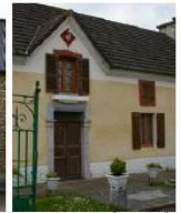
• A Sabouie, entrée travaillée en pierre de taille, lucarne fronton avec décor en briques.
