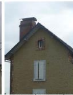
• A Esaubé, cheminée en briques, encadrements en pierres d'Arudy et en briques.
