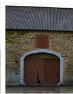
• A Lespoury, marquage de l'entrée de la grange avec encadrements en pierre de taille.
