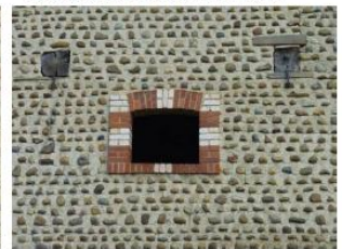
• A Serres-Morlaàs, murs en galets, encadrements en briques.
