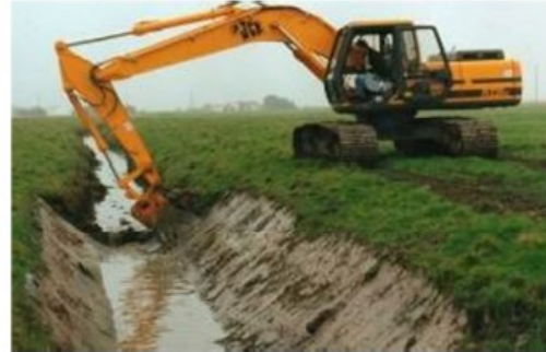
Figure 2 : Exemples de curage et reprofilage de fossé
