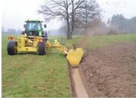
Figure 2 : Exemples de curage et reprofilage de fossé
