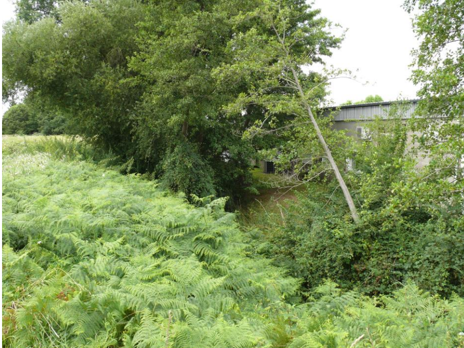
Construction très proche du lit du cours d'eau et absence de ripisylve en rive droite dans la zone d'activité à l'aval de la RD 834
