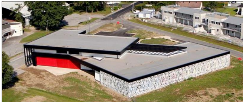
Fig. 33. Maison de la Musique à Montardon
