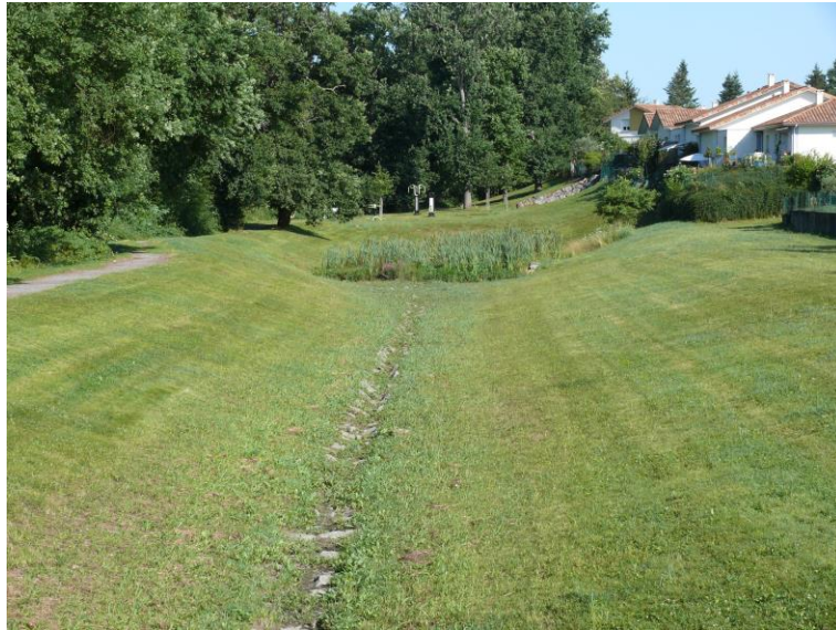
Zone humide artificielle de gestion des eaux pluviales à proximité du Luy de Béarn
