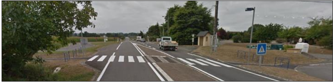
Fig. 58. Traversée RD834 aménagée (commune d'Astis)
