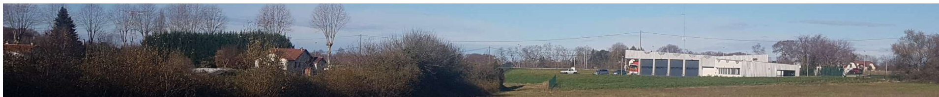
L'implantation du bâtiment du SDIS vient prolonger le Hameau Brun
