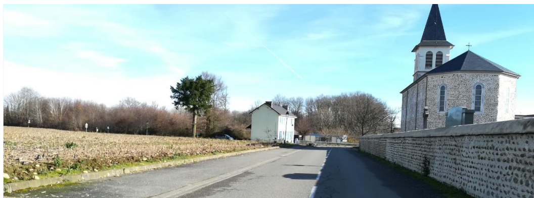
Fig. 2. Photo du secteur 1 depuis la route de Saint-Armou (source : Artelia)
