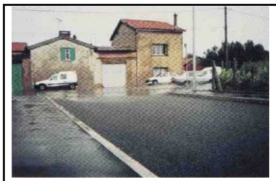
Contraste entre une chaussée classique et une chaussée drainante Source INSA de Lyon
