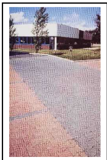
Parking réservoir et pavés drainants de la zone d'activités du Phare (33) Source CETE du Sud-Ouest
