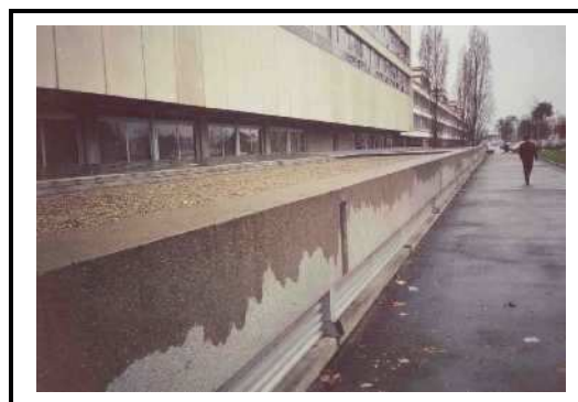
Aménagement en décroché de toiture-terrasse sur site hospitalier Source CETE du Sud-Ouest
