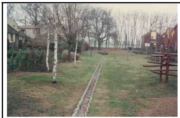
Noue et cunette en béton à Villaboiss Bruges (33) Source CETE du Sud-Ouest
