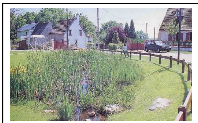
Noue engazonnée Opération Belbeuf – 76 Source Foncier Conseil
