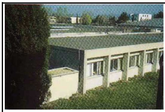
Toiture – terrasse Source CERTU
