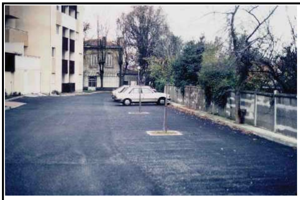
Tranchée sous enrobé poreux Source CETE du Sud-Ouest
