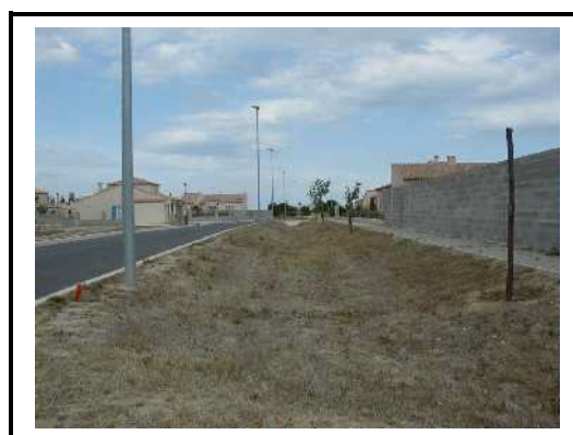
Noue en construction à Alénia Lotissement « les Vignes » Source DDE 66
