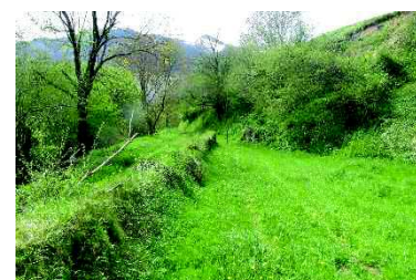
Aperçu du muret à conserver
