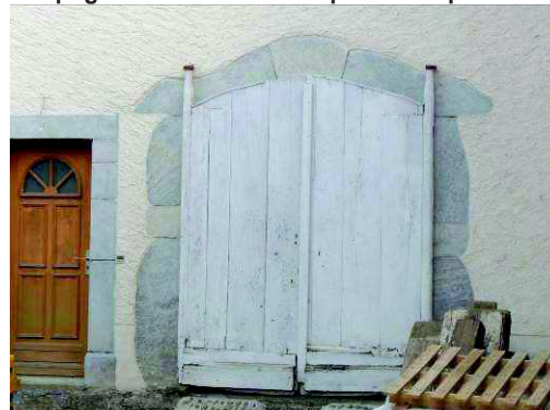
Baie avec jambage et linteau en granit
