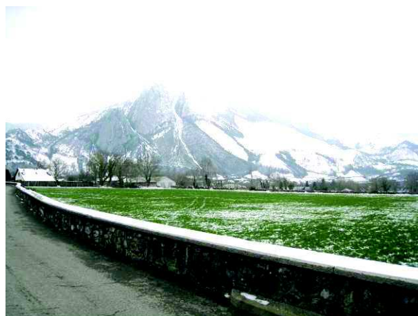
Muret de pierre moellon clôturant les unités agricoles en fond de vallée
