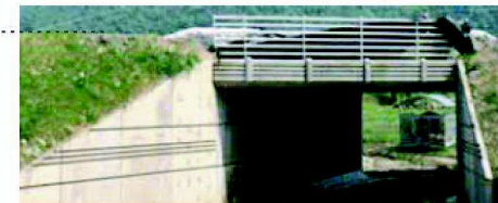
Ouvrage mixte hydraulique et boviduc
