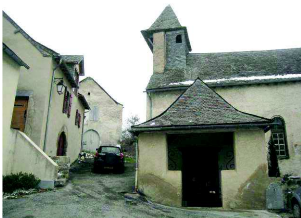
Toiture en ardoise
