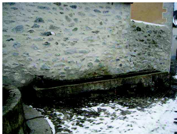
Abreuvoir Place de l'Eglise à Accous
