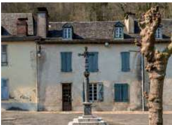
Le faitage est parallèle à la rue. La porte n'est pas centrée. Sarrance.
