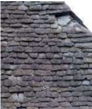
Ardoises épaisses posées au clou. Oloron Sainte-Marie.
