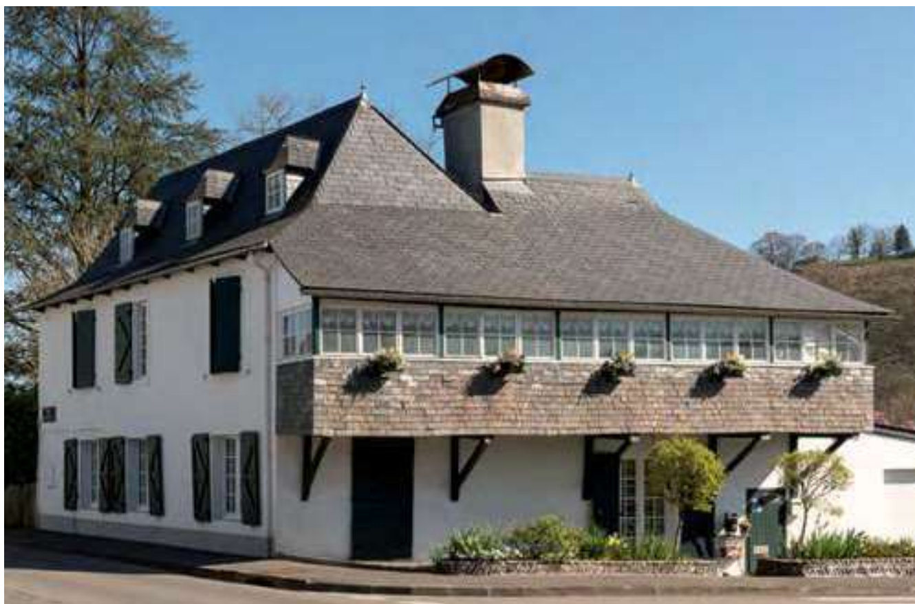
La galerie fermée est une extension de la maison qui présente des propriétés climatiques intéressantes en jouant le rôle d'espace tampon sur la façade. En hiver grâce à l'inertie thermique des ardoises elle emmagasine la chaleur du rayonnement solaire pour la redistribuer à la maison. Féas. Source : Pays d'art et d'histoire © Clément HERBAUX.
