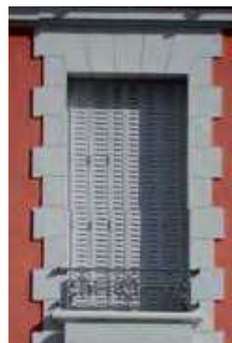
Volets repliables métalliques à persiennes.
