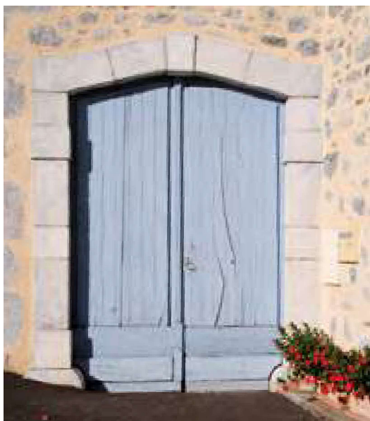
Porte à planches et contre-planches. Bescat.
