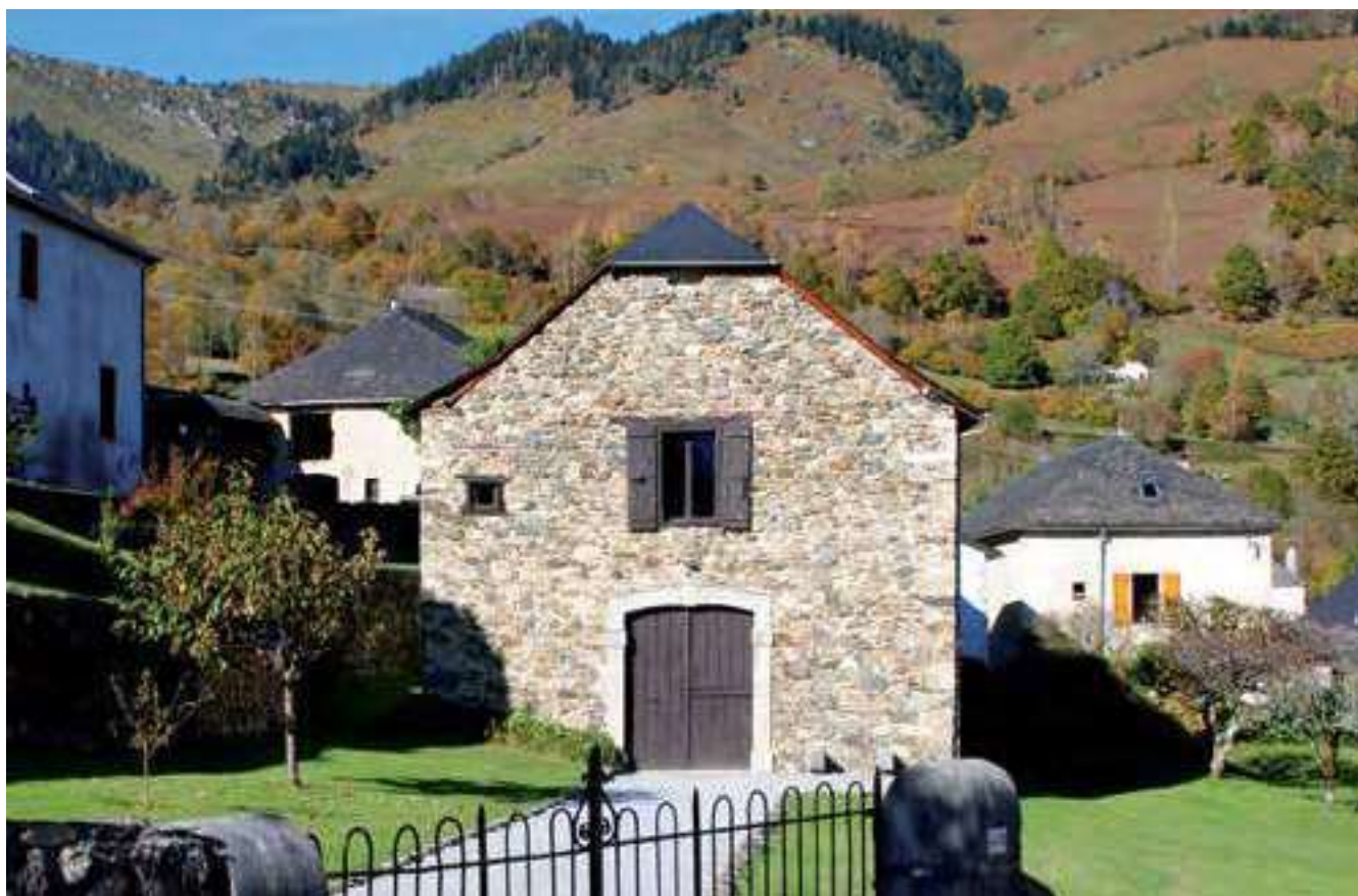
Habitation inscrite dans la pente, avec toiture en demi-croûpe. Billères en Ossau.
