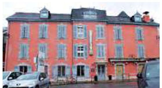
Architecture éclectique de la période industrielle. Oloron Sainte-Marie, place Mendiondou.
