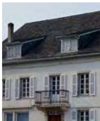
Lucarnes rampantes. Issor.
