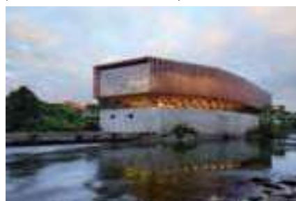
Médiathèque des Gaves, Pascale Guédot Architecte.
