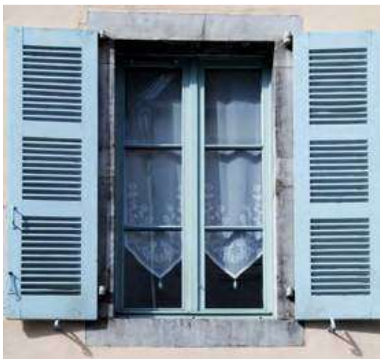
Contrevents à persiennes et partition de la fenêtre à grands carreaux. XX e siècle.
