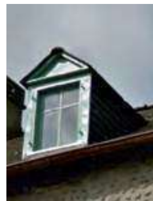
Lucarne jacobine, fronton en bois peint avec corniche, ardoise. Gurmençon.
