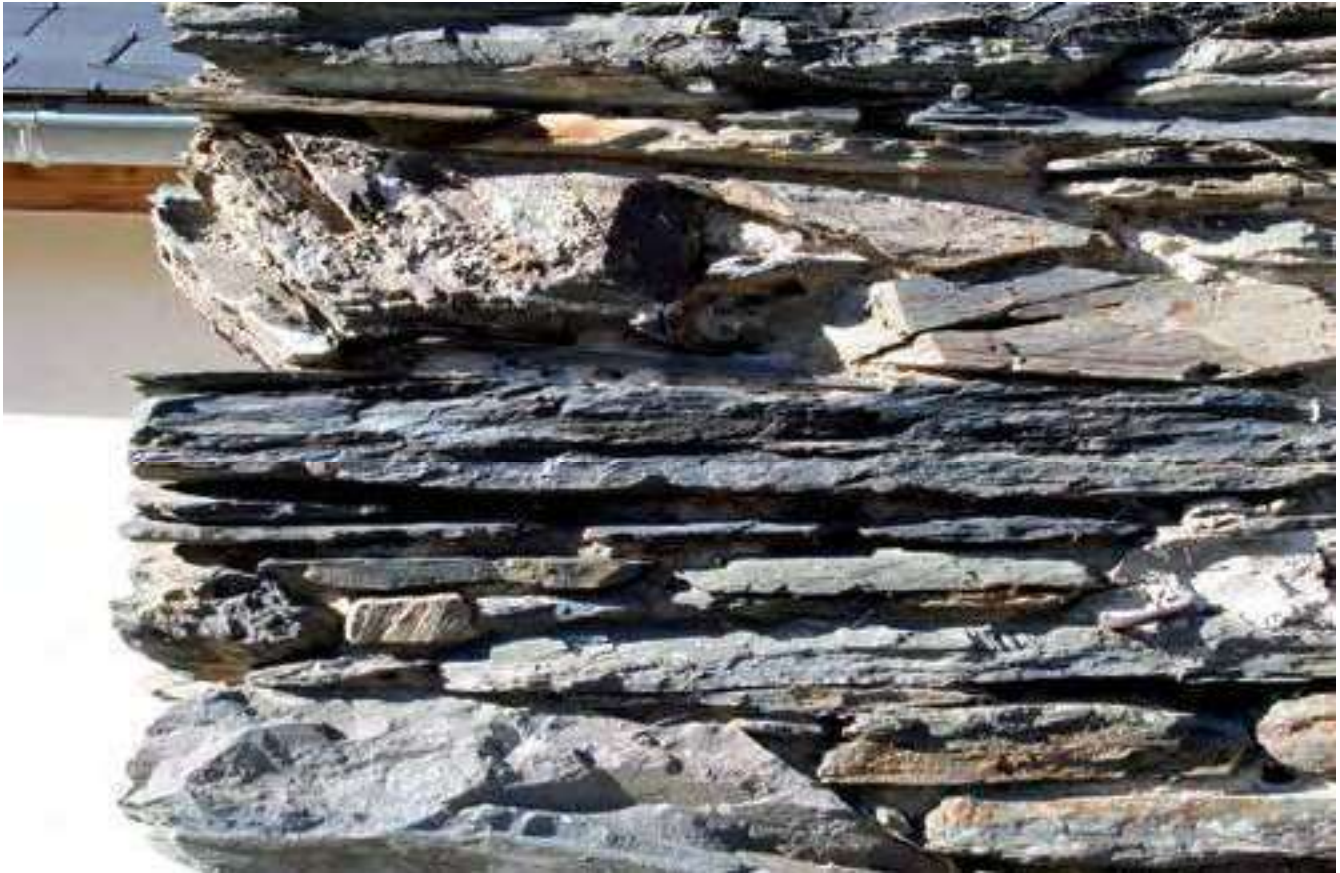
Dalles de schiste appareillées en maçonnerie de pierres sèches dans la vallée d'Ossau. Louvie Soubiron.
