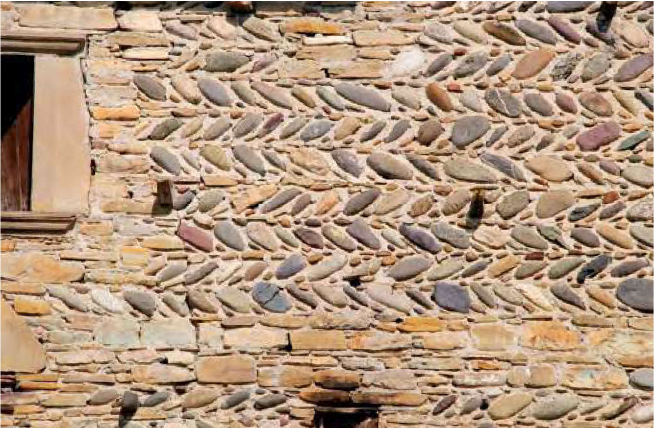
Appareillage d'un mur de galets en fougères, avec assises de pierre, assurant la stabilité. Malgré le soin apporté à ce dessin, il est destiné à être enduit pour valoriser les éléments d'encadrements en pierre. Poey d'Oloron.
