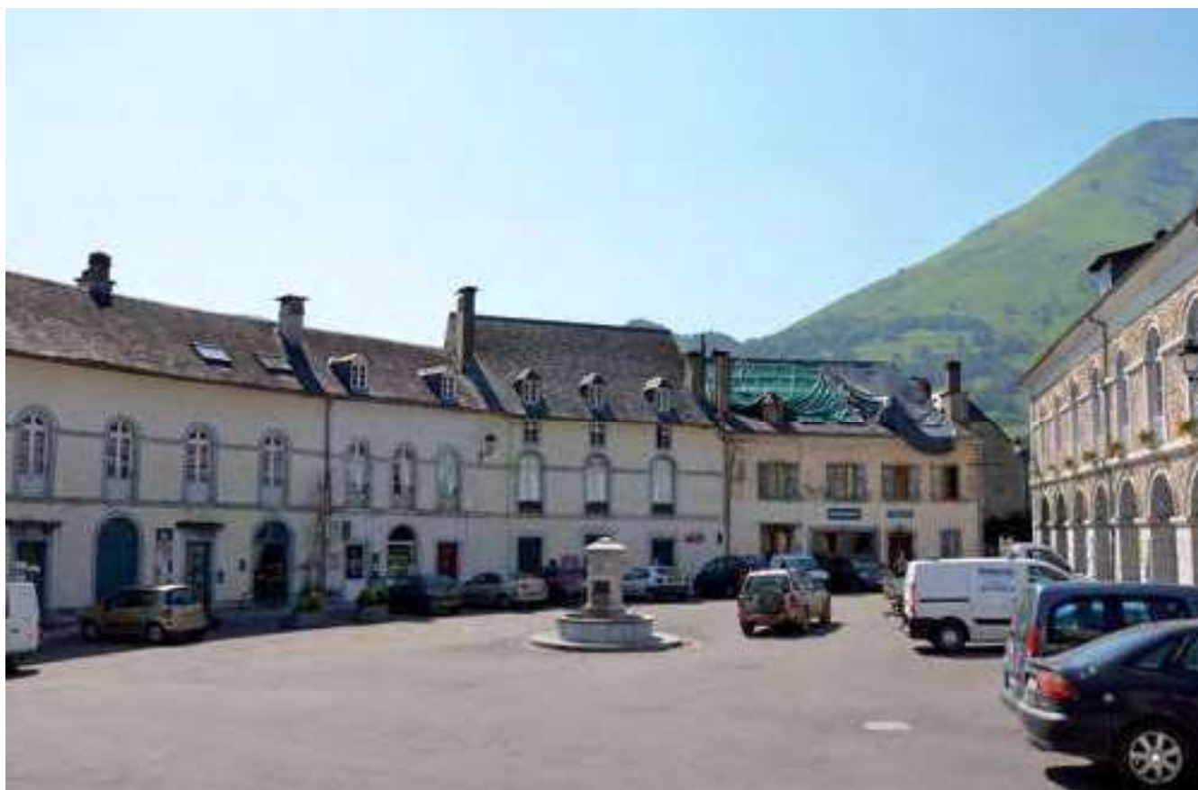
La place ordonnée, le rythme des façades fait écho aux arcades de la mairie-halle, le gabarit des maisons est réglé sur celui de l'hôtel de ville à R+1+ comble. La fontaine au centre de la place est l'équipement communautaire qui articule l'espace public. Bedous.
