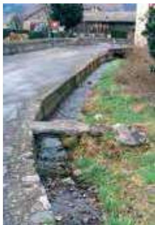
Les abords du village, le rapport à l'eau, les ouvrages. Léas-Athas.
