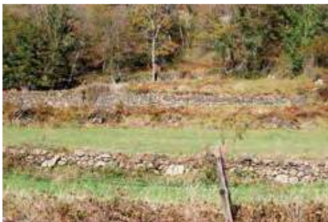
Terrasses et murs de soutènement en pierres sèches qui facilitent le drainage des terrains. Entre Bielle et Bihère, vallée d'Ossau.
