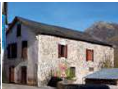
Toiture simple à deux pentes. Bielle.
