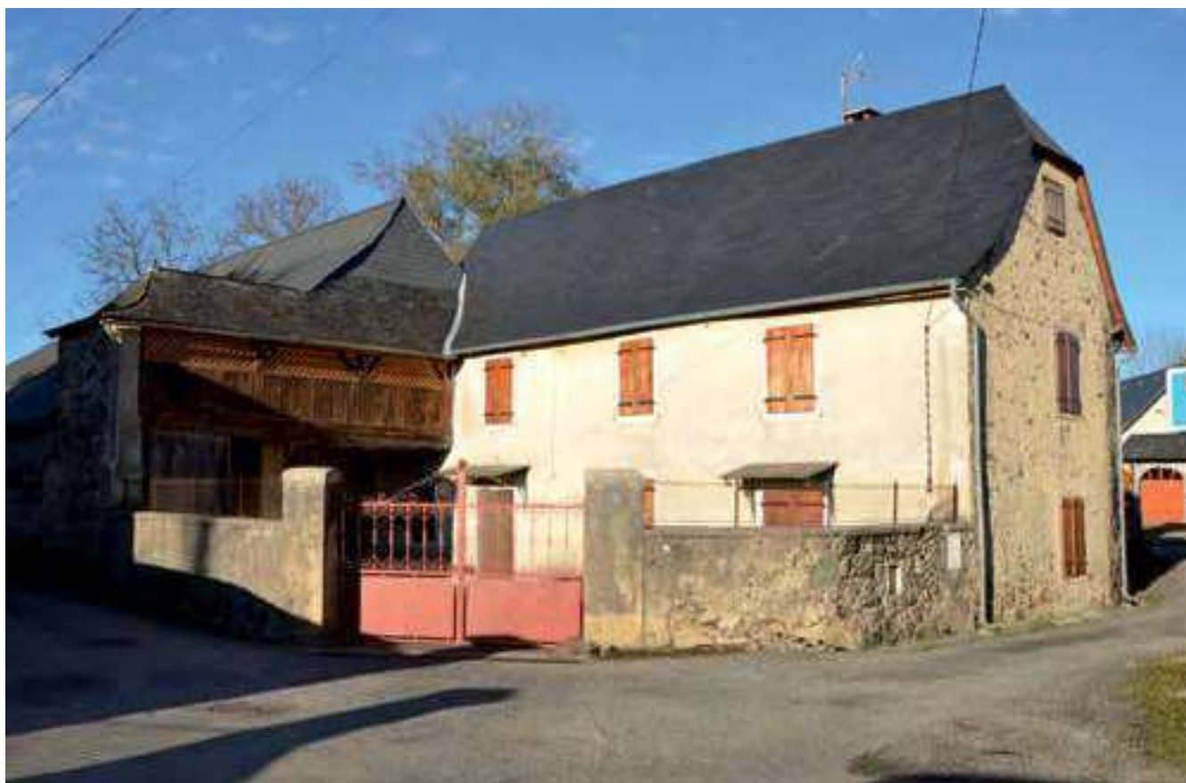
Organisation du bâti principal et des bâtis secondaires autour de la cour. Ogeu-les-Bains.
