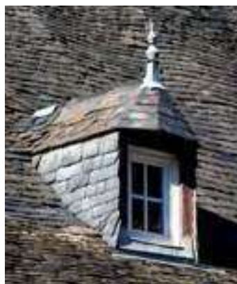
Lucarne à croupe avec épi de toit en zinc, joues en ardoise. Gère-Bélesten.
