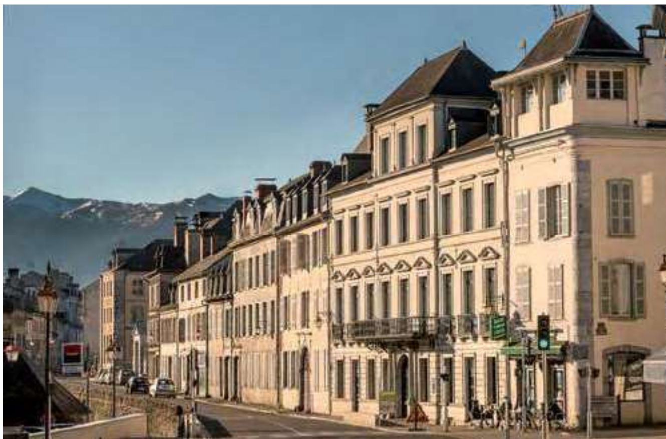
L'implantation urbaine réglée, l'alignement et la continuité des façades sur la rue Adoue, le motif urbain du quai sur le gave d'Aspe. Oloron Sainte-Marie. Source : Pays d'art et d'histoire © Clément HERBAUX.
