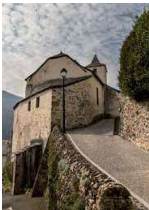
La rue soutenue par un mur à Aydius Source VPAH © Clément HERBAUX.
