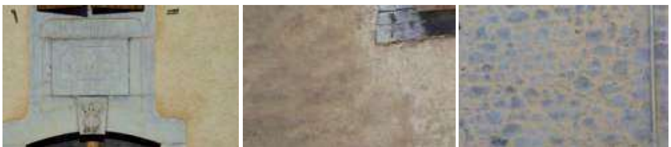
Badigeon coloré au pigments minéraux, finition talochée aux sables locaux et enduit coloré à pierre vue.
