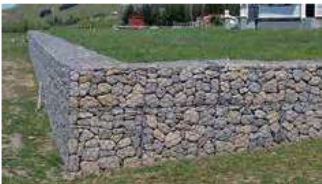
Exemple de murs gabions en soutènement.
