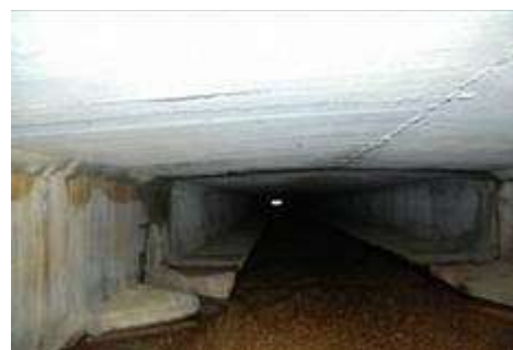
FIG. 19 : La « Mielle » canalisée
