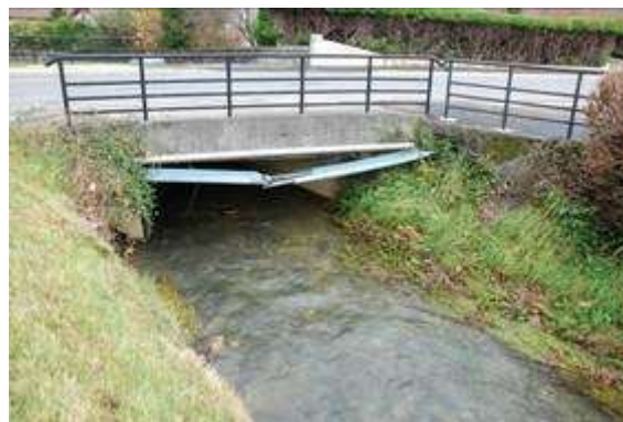
FIG. 13 : Bras 1 : « Miellotte » Ouvrage de franchissement rue des Basques
