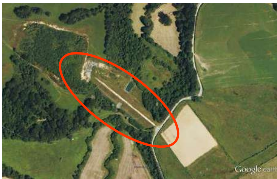
FIG. 7 : Photo du barrage écrêteur de crues des « Mielles » (source : Google Earth)
