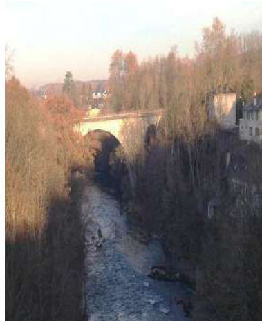
Pont de la voie SNCF sur le « Gave d'Oloron »
