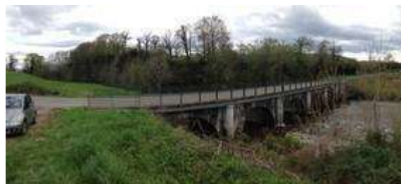
Pont sur la RD 24
