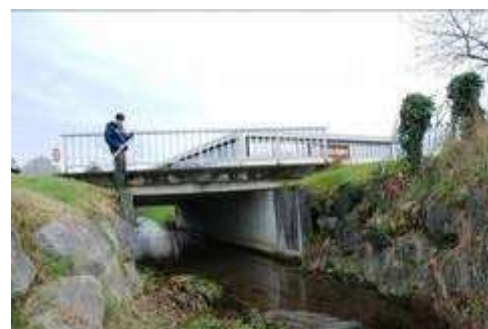
FIG. 23 : Ouvrage de franchissement Boulevard des Pyrénées
