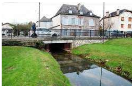
FIG. 22 : Ouvrage de franchissement Rue Tristan DEREME
