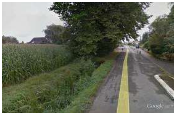
FIG. 14 : Bras secondaire intégrant réseau pluvial le long du boulevard Henri LACLAU (en aval du quartier Pondeilh) - (source Google Earth)
