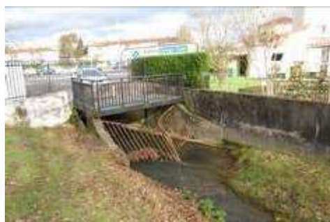
FIG. 18 : Ouvrage et canalisation de la « Mielle »
