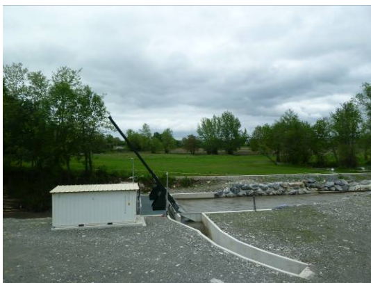
Aménagement hydraulique sur le Gave, au sud-est du territoire de Nay
