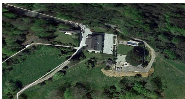
Vue aérienne sur les installations du château de Langladure
