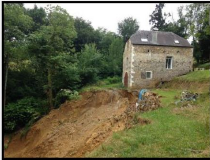
Glissement de terrain sur la commune de Narcastet
