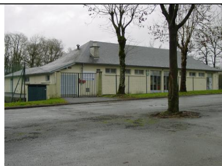
Bâtiment de la piscine du camping (ouest du bourg de Morlaàs)
