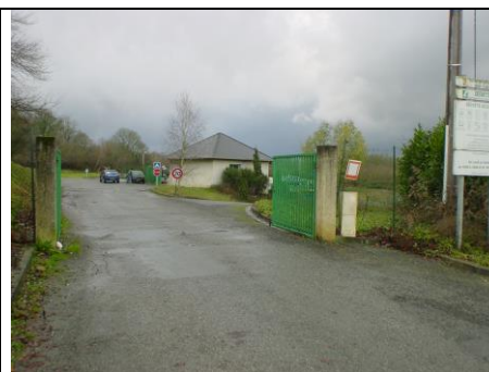
Entrée de la déchèterie (quartier du Basacle)
