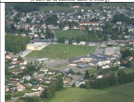
vue aérienne sur le CES et les stades
