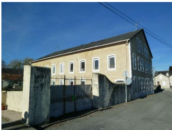
Des corps d'usine réhabilités en logements collectifs
