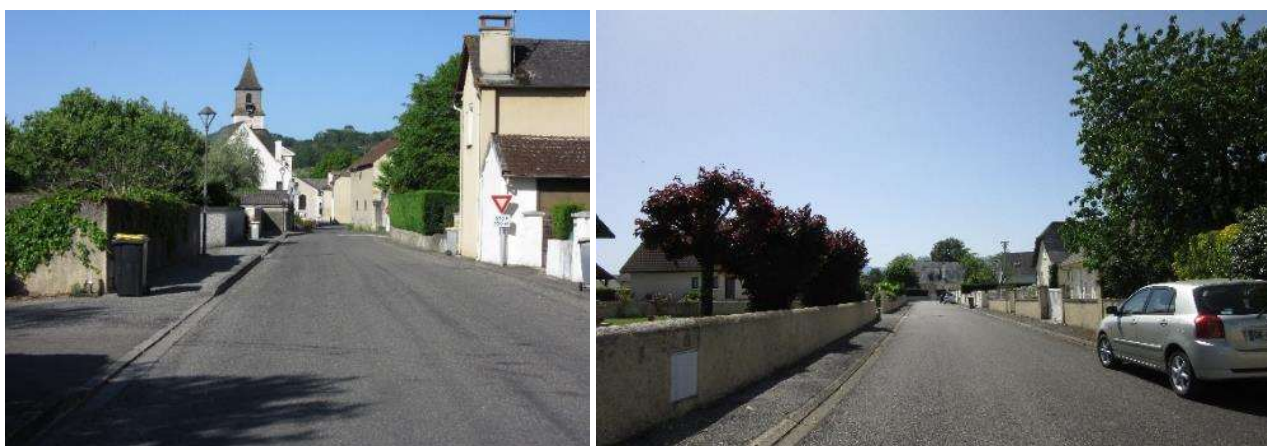
Trottoirs en centre bourg et dans le lotissement les hauts du Gave (largeur variable, non conforme PMR, stationnement pouvant être gênant sur les trottoirs)
