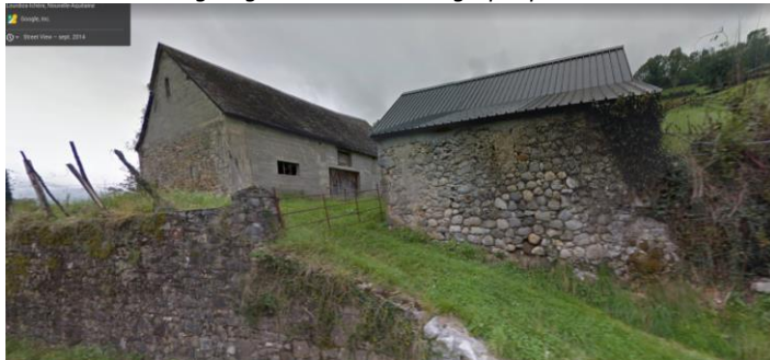
Vue des bâtiments (Google street view)
