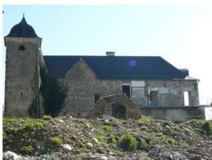
Photos ci contre : bâti traditionnel et le château de la Verlée
