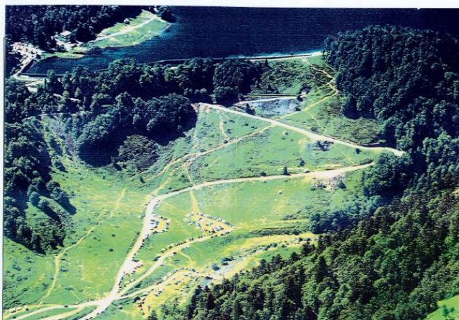
Vue aérienne sur le barrage en été (1999). Au premier plan, le plateau des Oumettes utilisé temporairement en parking, avec au-dessus les réseaux de sentiers piétons jusqu'au lac. Au bord du lac de Bious-Artigues, la zone d'accueil : cantine-refuge et parking.
