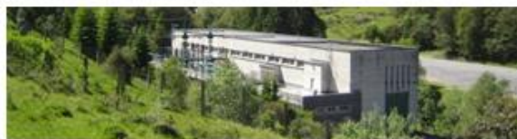
1- La centrale hydroélectrique
