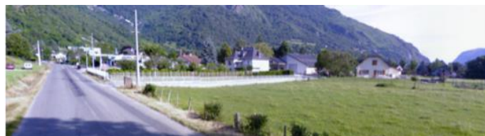
Entrée Sud depuis la rue de Gerp
