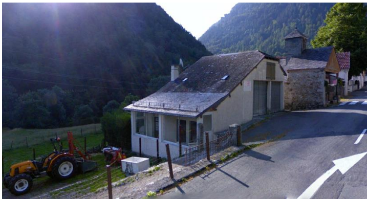
Vue sur le bâti implanté au Sud contre la RD 934
