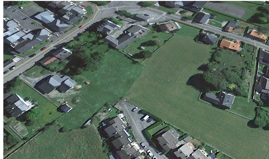
Vue aérienne du branchement sur la rue Barou au niveau du lotissement existant
