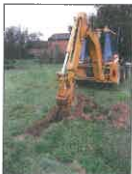
Réalisation d'une fosse (photo SESAER)
