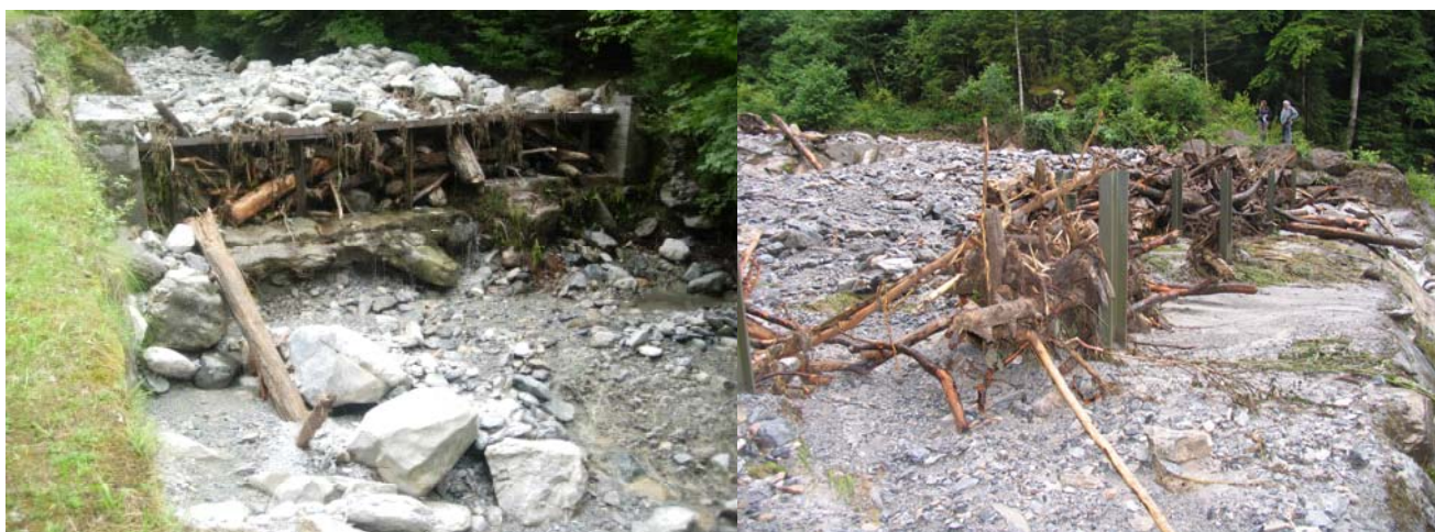
Pièges à matériaux dans le lit du torrent la Sourde (Eaux-Bonnes) crue du 6 août 2009
