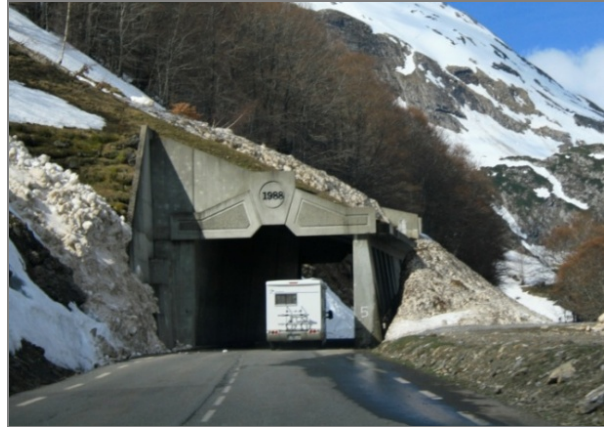
Ouvrages de protection passive sur la route du col du Pourtalet (digue de protection et paravalanche)
