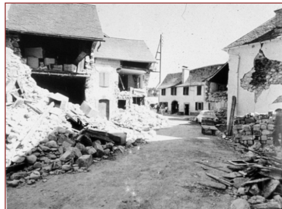
Une rue du village d'Arette après le séisme
