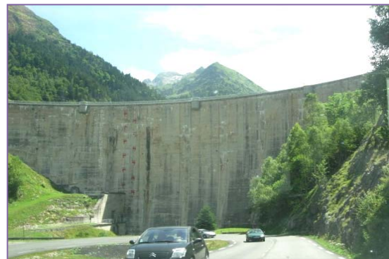
Barrage de Fabrèges
