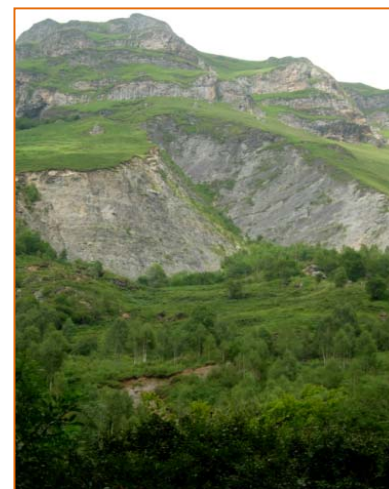
Glissement de Pleysses (Eaux-Bonnes)
