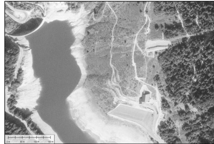
Figure 8 – Vue de la première version “courte” de la digue directement à la sortie de l’étranglement du couloir en septembre 1983 (source Géoportail “remonter le temps”)
