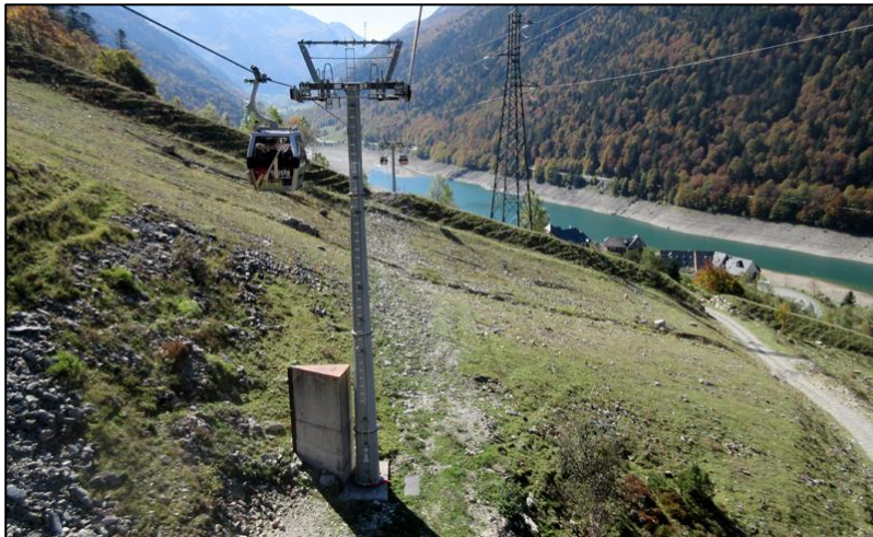
Figure 7 – Vue de l’étrave au niveau du pylône de la télécabine d’Artouste le plus proche de la trajectoire de l’avalanche de Pan d’Aulière (source : www.remontees-mecaniques.net ) – au fond vue de la digue
