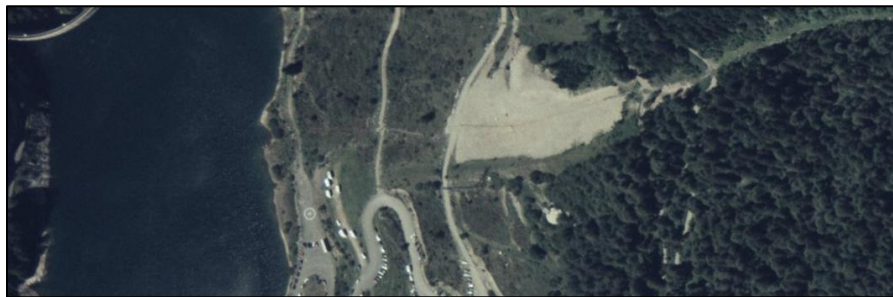
Figure 12 – Traces du terrassement du chenal d’écoulement à la fin des années 1990 (source : Géoportail, remonter le temps)
