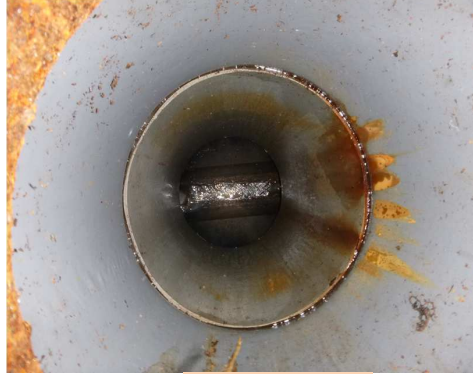
Infiltration sur boite de branchement
