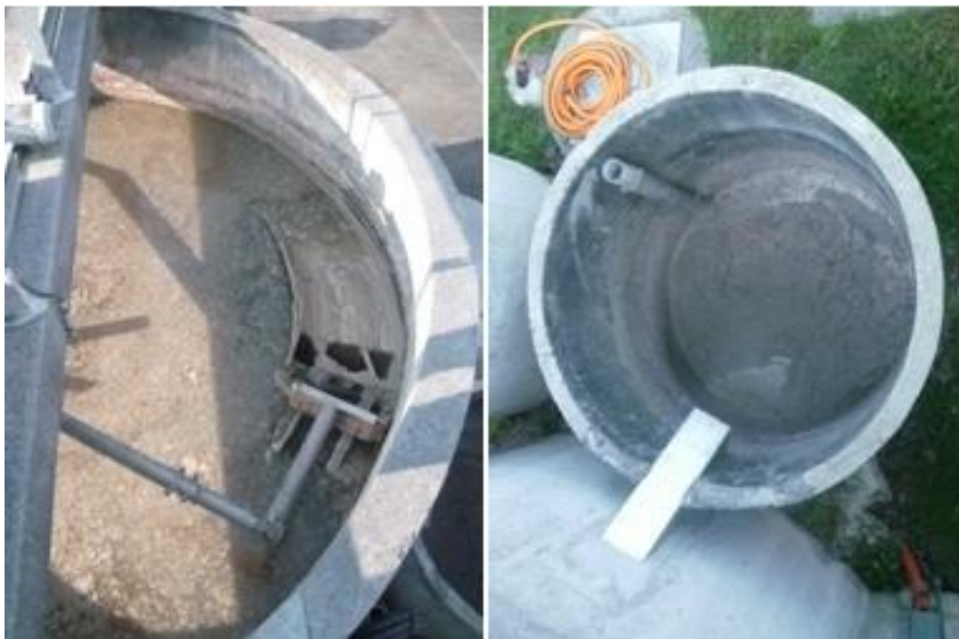
Figure 28 : STEP / Vues dégraisseur/dessableur et sur le silo de récupération des flottants
