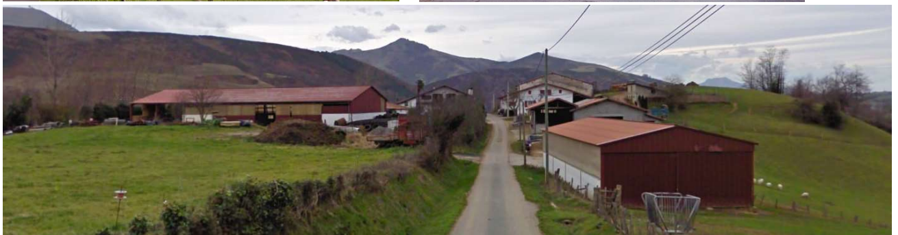
Quelques exemples de constructions agricoles peu insérées dans le grand paysage
