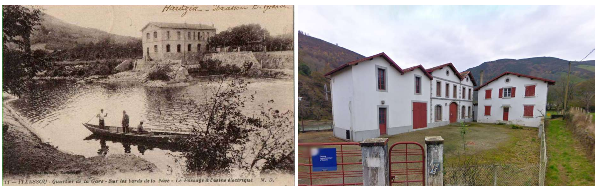
Centrale hydroélectrique d'Ixassou sur la Nive
