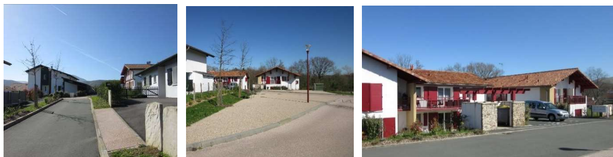
Voirie, espace public et logements collectifs dans l'opération Oilomokonia (Source : APGL64)
