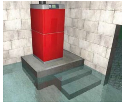
Mise hors d'eau par surélévation
