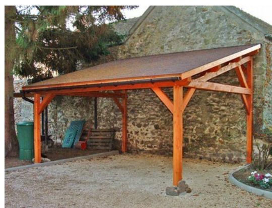
Abri de protection accolé à bâtiment (adjonction)
