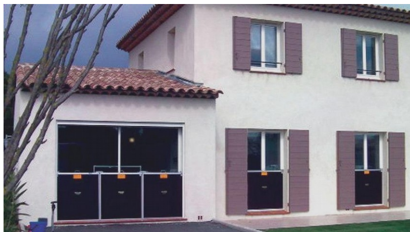
Exemple de protections des ouvertures
