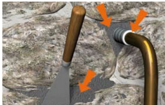
Situation après travaux de colmatage
