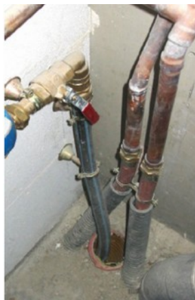
Exemple d'entrées de réseaux à calfeutrer
