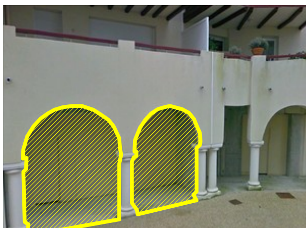
Obturation d'une travée de galerie
