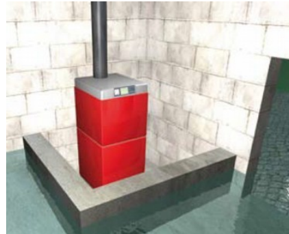
protection par disposition étanche
