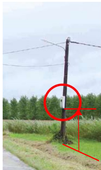
ETE du sud-ouest.
