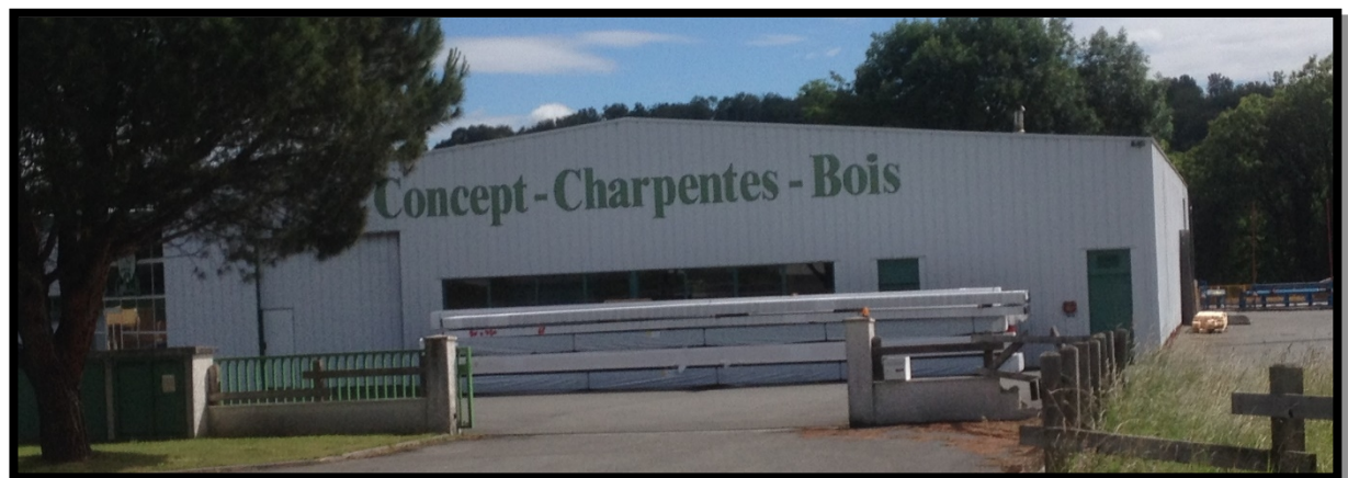
Bâtiment : Charpente. Entreprise Concept Charpente Bois
