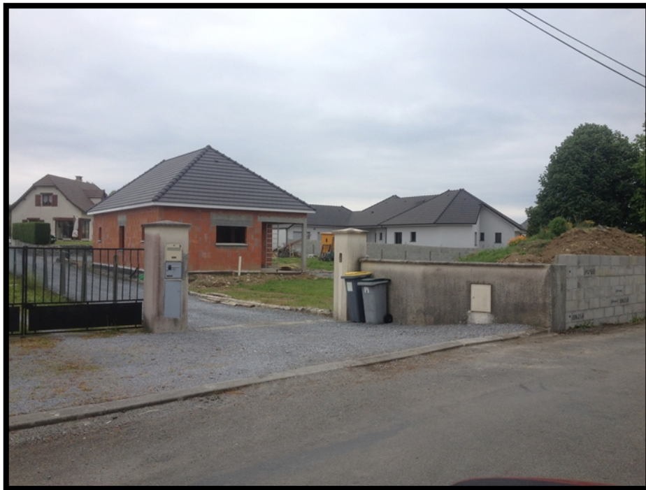
Construction récente sur la commune d'Igon
