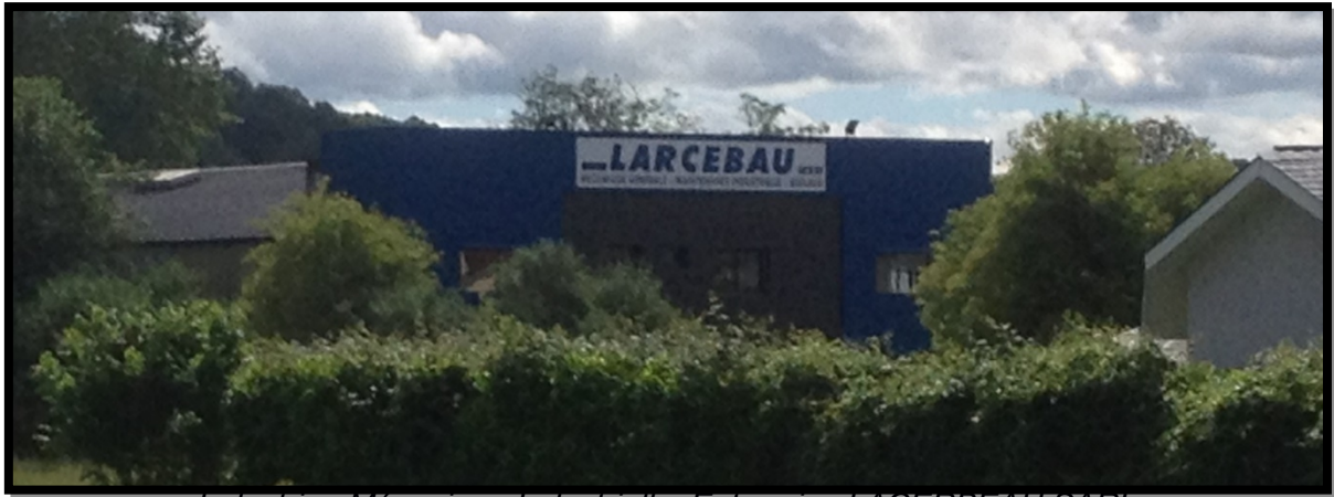
Industrie : Mécanique Industrielle. Entreprise LACERBEAU SARL
