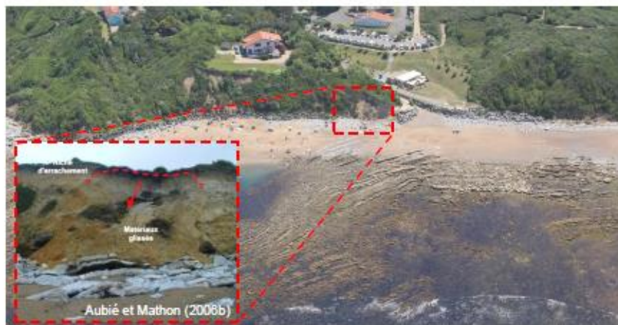
Figure 31 : Glissement de terrain dans les altérites, anse de Senix (© Observatoire de la Côte Aquitaine, Michel Le Collen, 2013).
